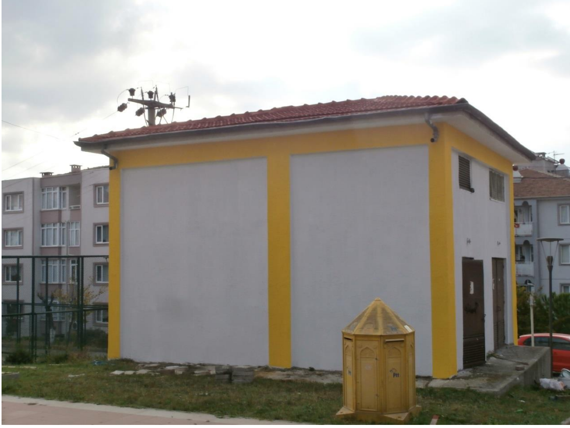
Şekil 26: Bursa Nilüfer 8-3 no'lu trafonun renkli reflektif çatı boyası ile boyanmış hali
