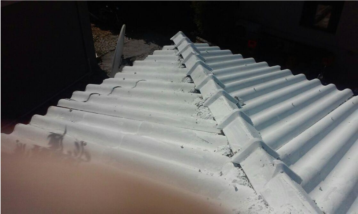
řekil 10: İstanbul Etiler'de Trafo binası atısının uygulama sonrası grnm
