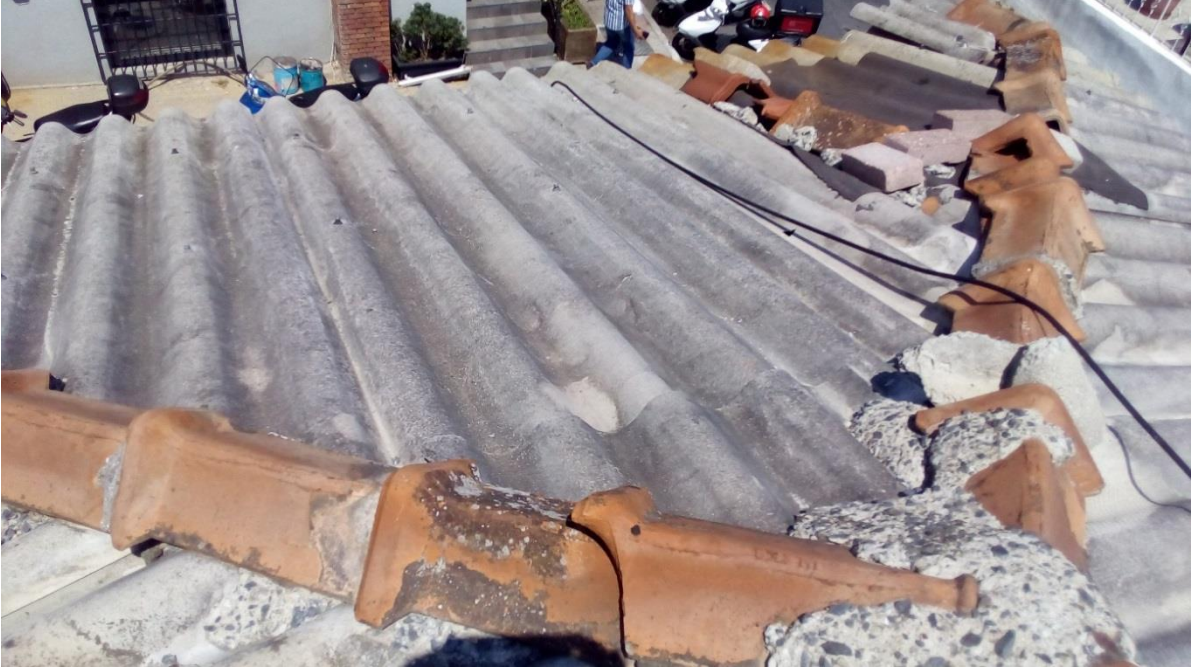
řekil 9: İstanbul Etiler'de trafonun uygulama ncesi atı grnm
