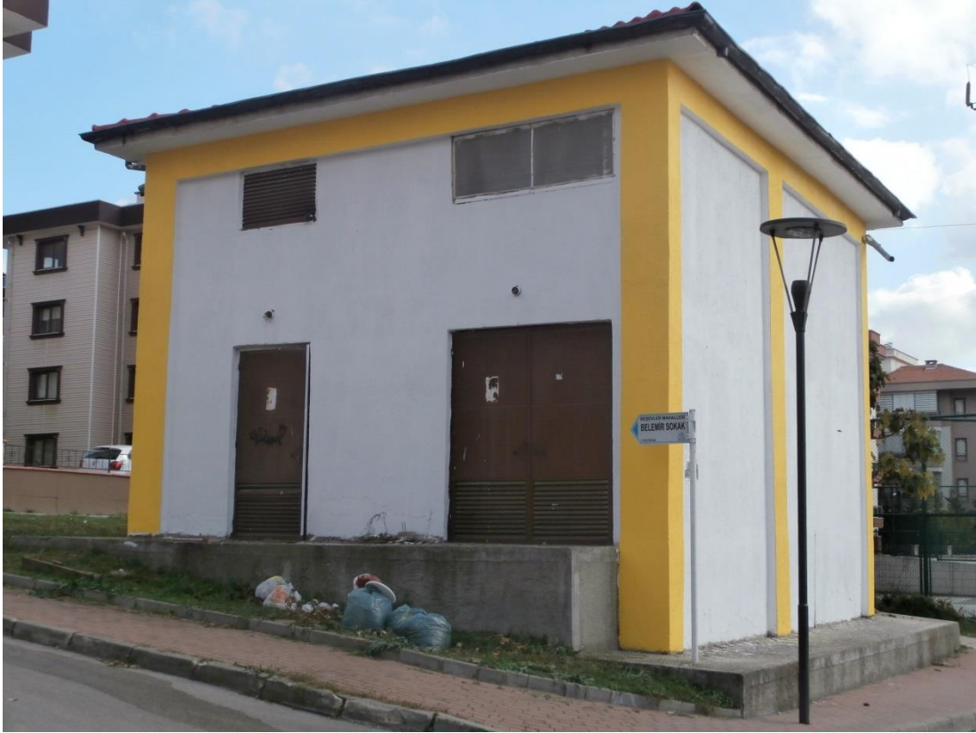
Şekil 25: Bursa Nilüfer 8-3 no'lu trafonun renkli reflektif boyalarla boyanmış hali
